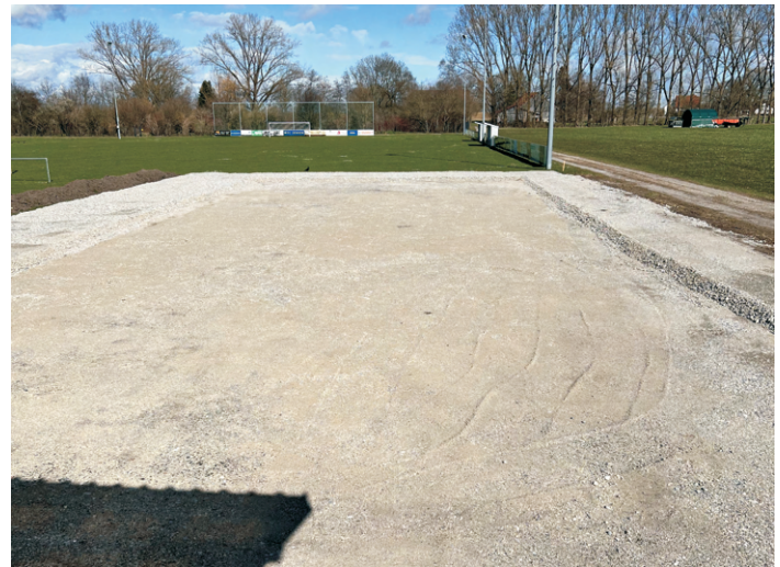
Abriss- und Befestigungsmaßnahmen in Vorbereitung auf die Pflasterarbeiten des Spezialunternehmens
