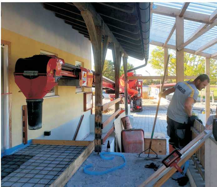
Neue Betonfundamente zur Erneuerung des Eingangsbereichs am Sportheim
