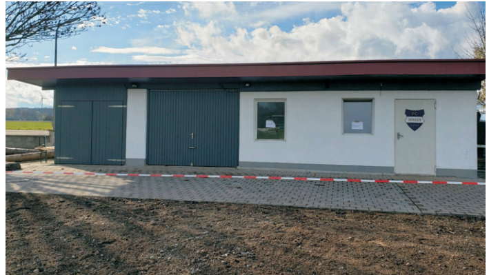
Unser Nebengebäude mit ehemaligem Stockraum, Ballraum und Werkstatt vorher (Bild oben) und nach den Renovierungsarbeiten (Bild unten)
