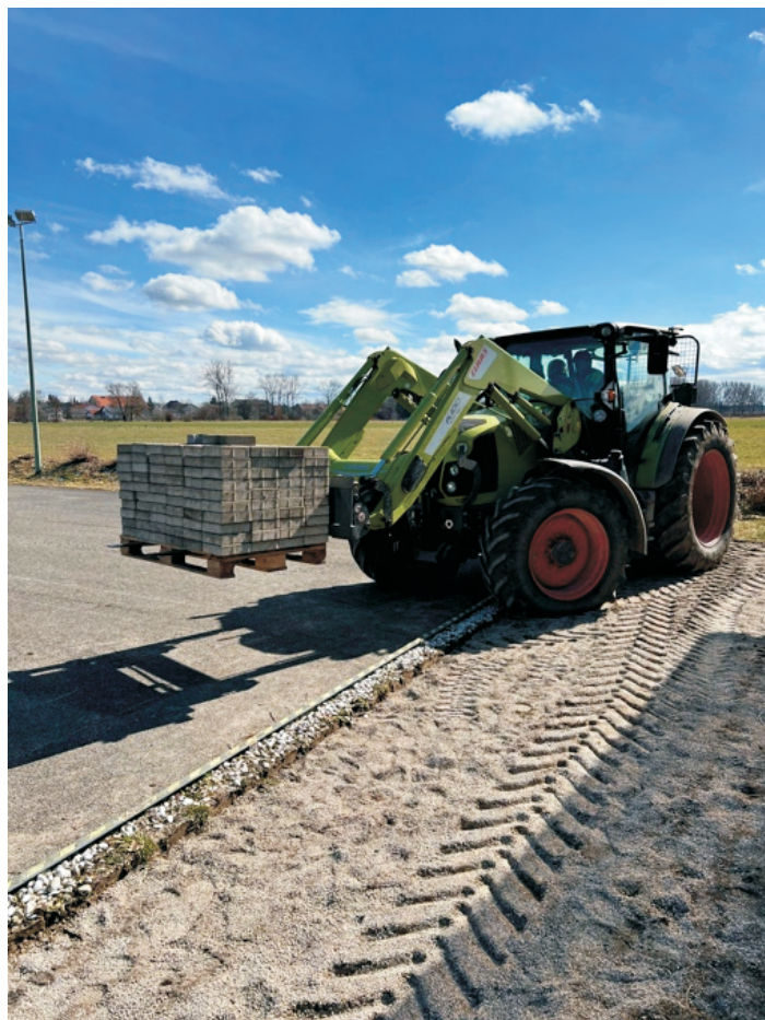
Die Pflastersteine wurden auf Paletten sortiert und mit schwerem Gerät zum Zwischenlager befördert
