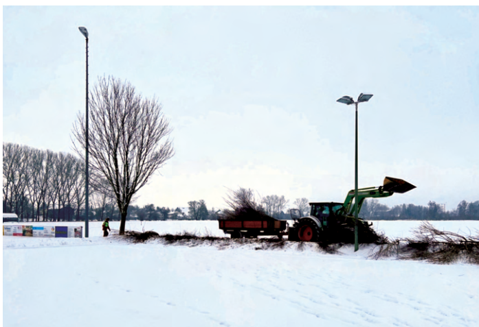
Erste Entrümpelungsmaßnahmen an der alten Stockbahn bei Schnee und eisigen Temperaturen
