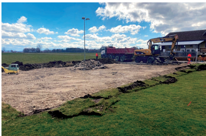
Vorbereitungen des Untergrunds für die anstehenden Pflasterarbeiten an der neuen Stockbahn
